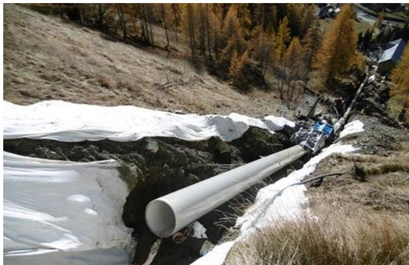
Le operazioni di scavo e posa della condotta sono state effettuate in tre aree separate del tracciato e, in totale nel 2015, sono stati approvvigionati, posati e saldati circa 1000 metri di tubazione. Sono inoltre state portate a termine le attività di realizzazione dei pozzi inclinati mediante macchina Raise Boring. L'avanzamento dei lavori è risultato in linea con le previsioni contrattuali.
