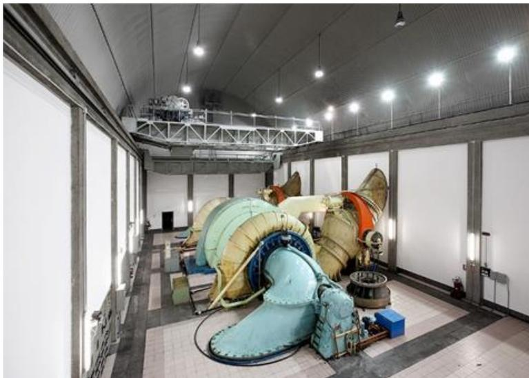
Nel mese di maggio 2015 è entrato in servizio il nuovo gruppo di produzione dell'impianto di Quart. Si è così completata la 1° fase del cantiere che ha preso avvio nel mese di luglio del 2014. Tale fase prevedeva la rimozione e la sostituzione della turbina sul "lato Châtillon" del vecchio gruppo, e la realizzazione dei nuovi locali quadri con l'installazione della nuova quadristica.
