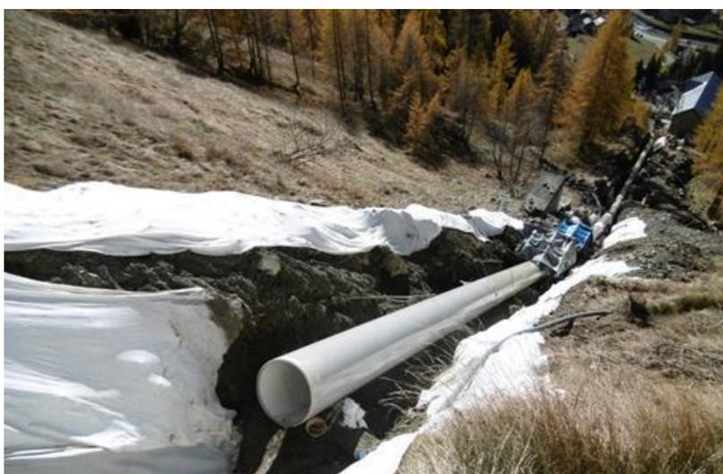
Le operazioni di scavo e posa della condotta sono state effettuate in tre aree separate del tracciato e, in totale nel 2015, sono stati approvvigionati, posati e saldati circa 1000 metri di tubazione. Sono inoltre state portate a termine le attività di realizzazione dei pozzi inclinati mediante macchina Raise Boring. L'avanzamento dei lavori è risultato in linea con le previsioni contrattuali.
