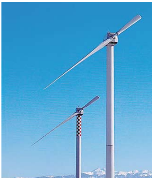
Figura 1.14 - Turbine a singola pala munita di contrappeso
