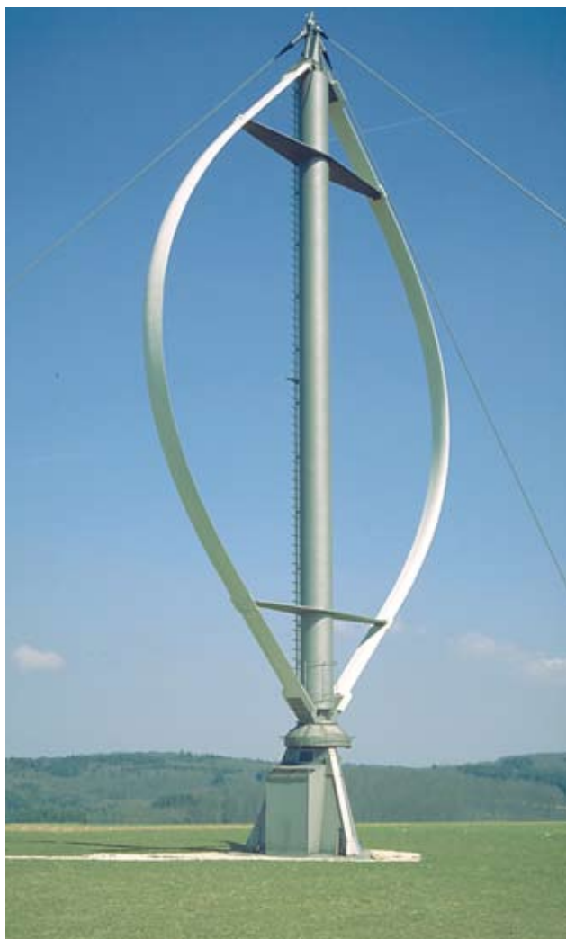
Figura 1.9 - Turbina tipo Darrieus
