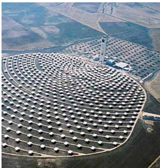
Figura B.8 - Impianto a ricevitore centrale
